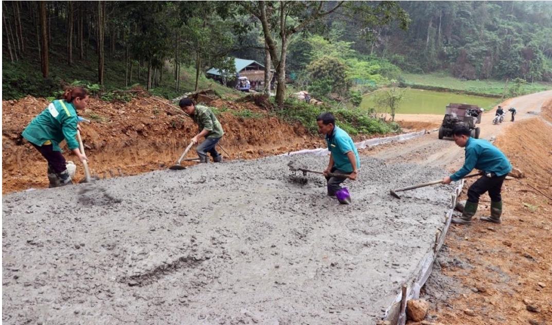
Ảnh 3: Người dân xã Trung Minh, huyện Yên Sơn (cũ) làm đường bê-tông nông thôn theo phương châm “Nhân dân làm, Nhà nước hỗ trợ” giai đoạn 2016 - 2020
